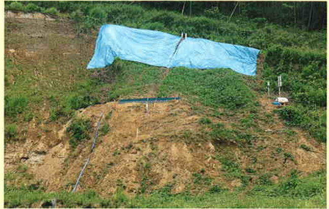
計測対象土砂斜面
